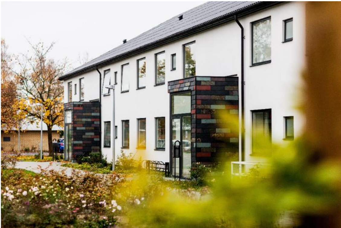
Nyrenoverede boliger for HØNG boligselskab, 2015
